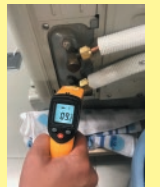
配管表面温度測定
